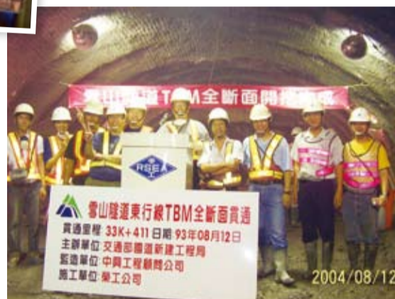
雪隧東行線TBM全断面貫通。
